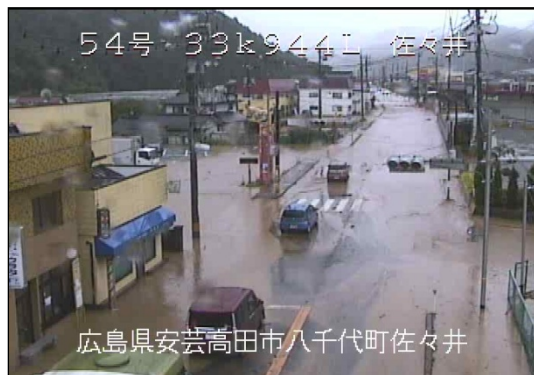
大雨による冠水 国道54号 広島県安芸高田市 令和3年8月13日
