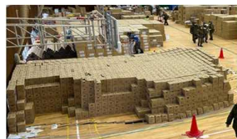
床が抜け落ちた体育館
