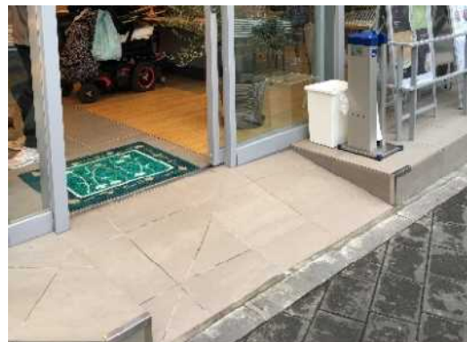
スロープの設置
