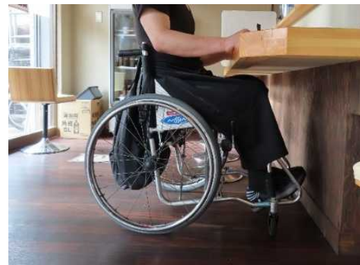
ローカウンターの設置
