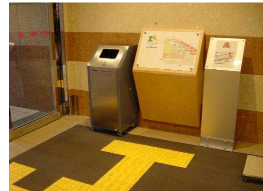
点字ブロック、点字案内板の設置 1
