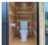
災害用トイレ の整備
