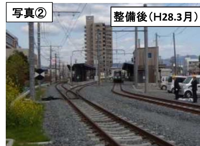
線路の接続部分
