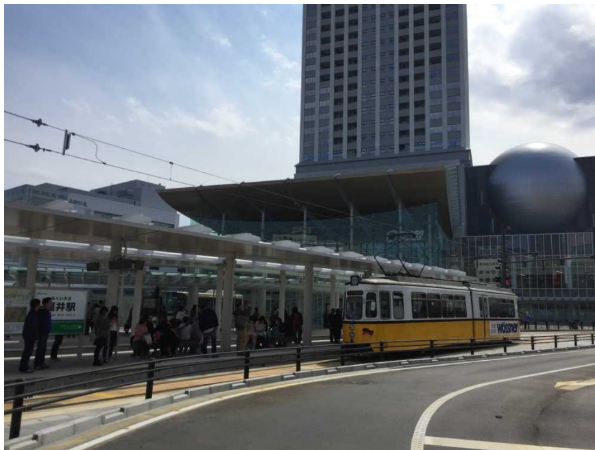
福井駅西口広場に延伸された福鉄福井駅 ※停車している車両は福井鉄道のレトラム
