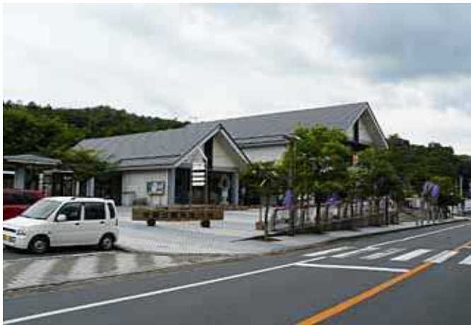
整備前の駅前広場及び駅舎
