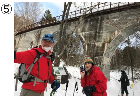
⑤ 目的地である橋梁は、ツアーの最後にハイライトとして下から見学。
