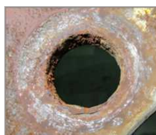
ホイールのボルト穴の損傷
