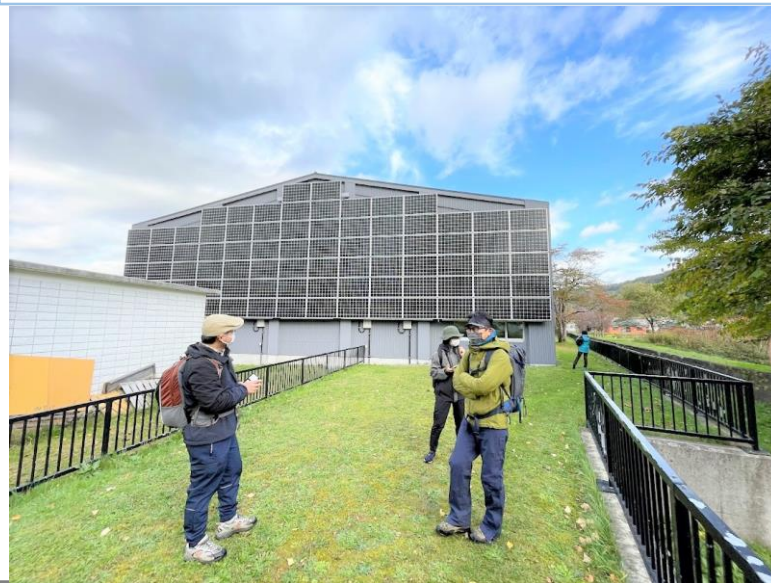
小学校の壁面に貼られたソーラーパネル
