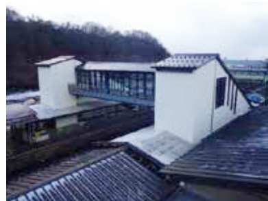
登別駅EV設置工事 (写真提供：J R 北海道)
