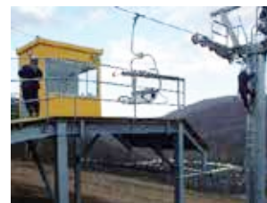
索道施設の完成検査
