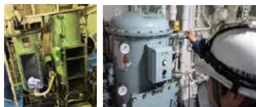
油水分離装置の解放の様子(左) 動作を確認する船舶検査官(右)
