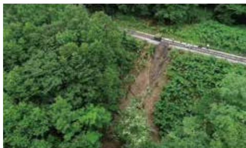
令和5年8月に発生した石北線盛土流出現場(左)と復旧作業の様子(右)
