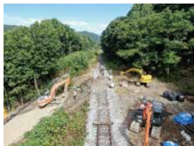
令和5年8月に発生した石北線盛土流出現場(左)と復旧作業の様子(右)
