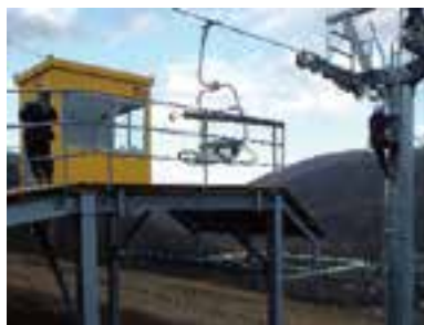
索道施設の完成検査
