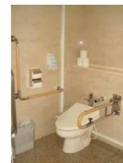
■ バリアフリートイレの整備
