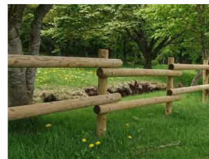
保護柵の整備
