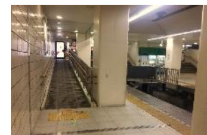
■段差の解消(スロープ)
