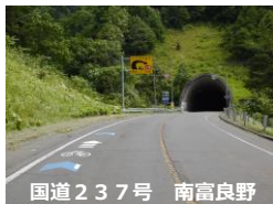
国道237号 南富良野
