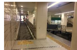
■段差の解消(スロープ)
