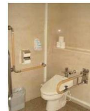
■バリアフリートイレの整備
