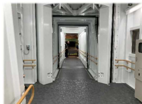
フェリーと搭乗橋の接続部
