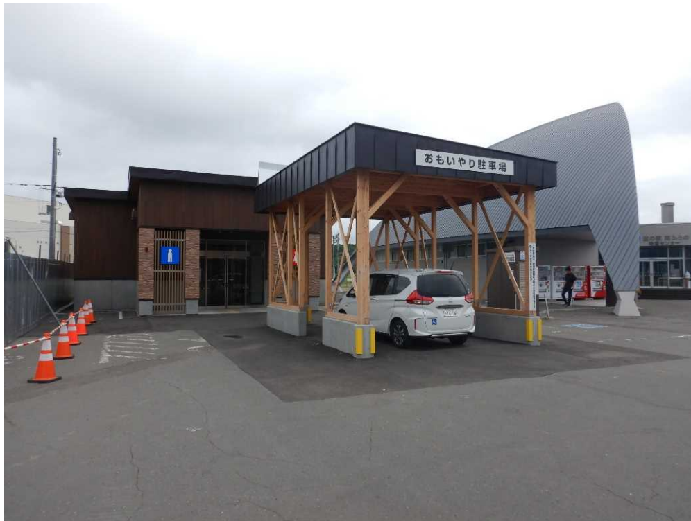
▼外観(トイレ・身障者・妊婦用屋根付き駐車場)
