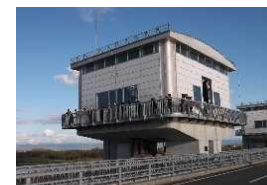
石狩川頭首工
