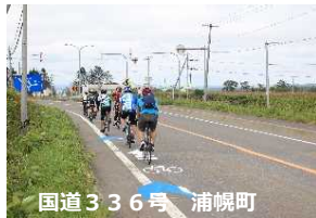
国道336号 浦幌町
