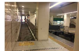
■段差の解消(スロープ)
