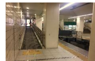
■段差の解消(スロープ)
