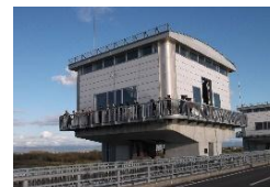
石狩川頭首工
