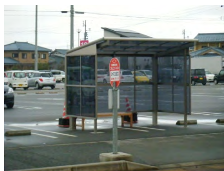
▲店舗側が新設したバス停（H21.7 新設）
