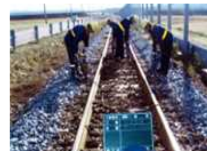
レールの修繕
