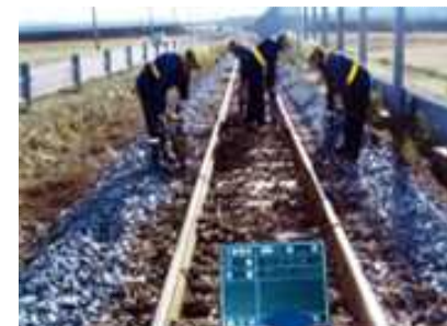
レールの修繕
