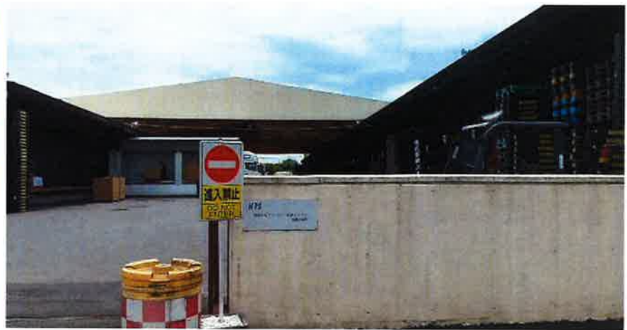
栗橋 DC の外観
