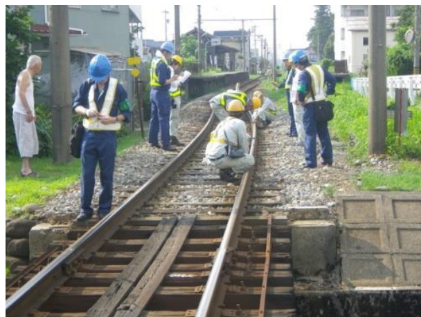
土木：軌道測定
