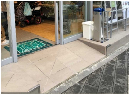
スロープの設置
