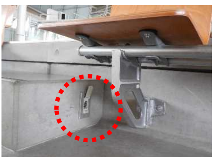
集団補聴設備の設置
