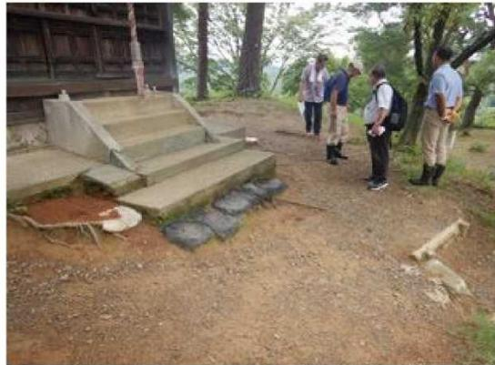
⑩4 毘沙門堂階段のモルタルの剥離、雨水により
