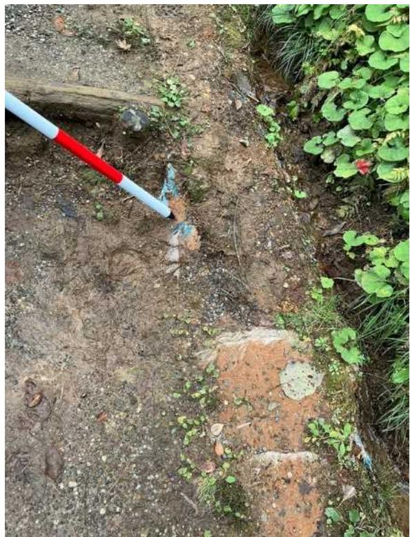
写真 2-11 遊歩道の土囊使用状況
