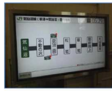
駅(停留所)に設置されたバス・ロケーションシステム
