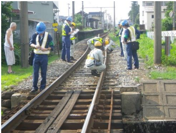
土木：軌道測定
