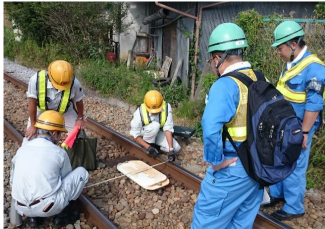
電気：A T S 地上子測定
