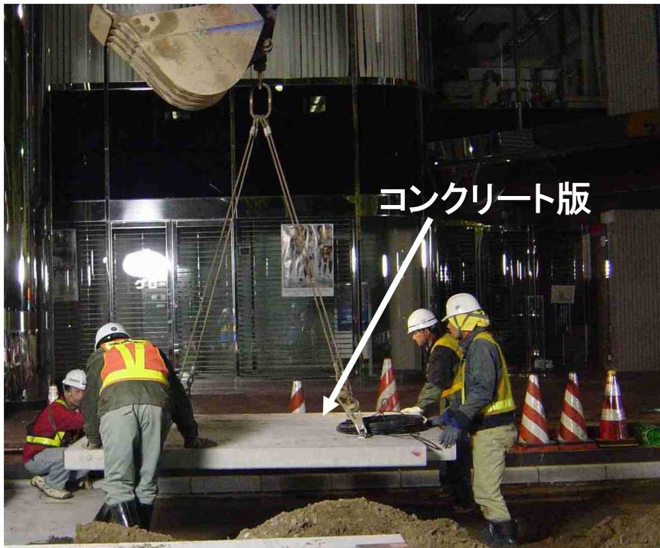
写真 コンクリート版設置状況
