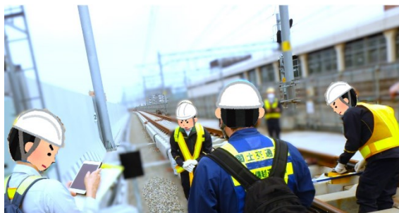
土木：完成検査（軌道）
