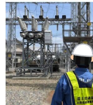
電気：保安監査（変電所）
