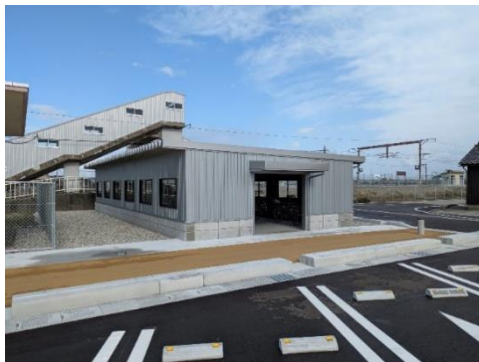
西入善駅前駐輪場の新設 (R6.12供用開始)
