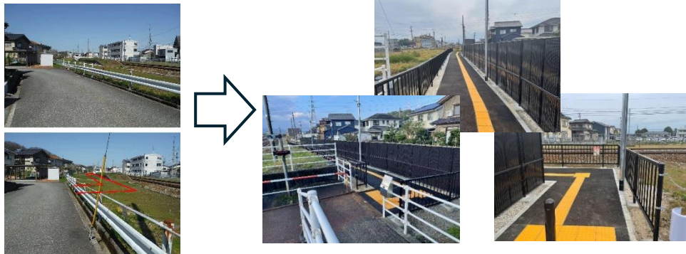
西富山駅西側アクセス通路 (R7.3.27供用開始)
