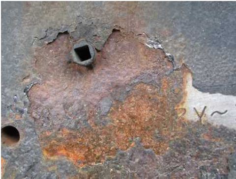
腐食し識別困難となった車台番号
