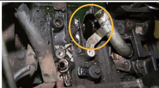
＜エンジンの破損状況＞
