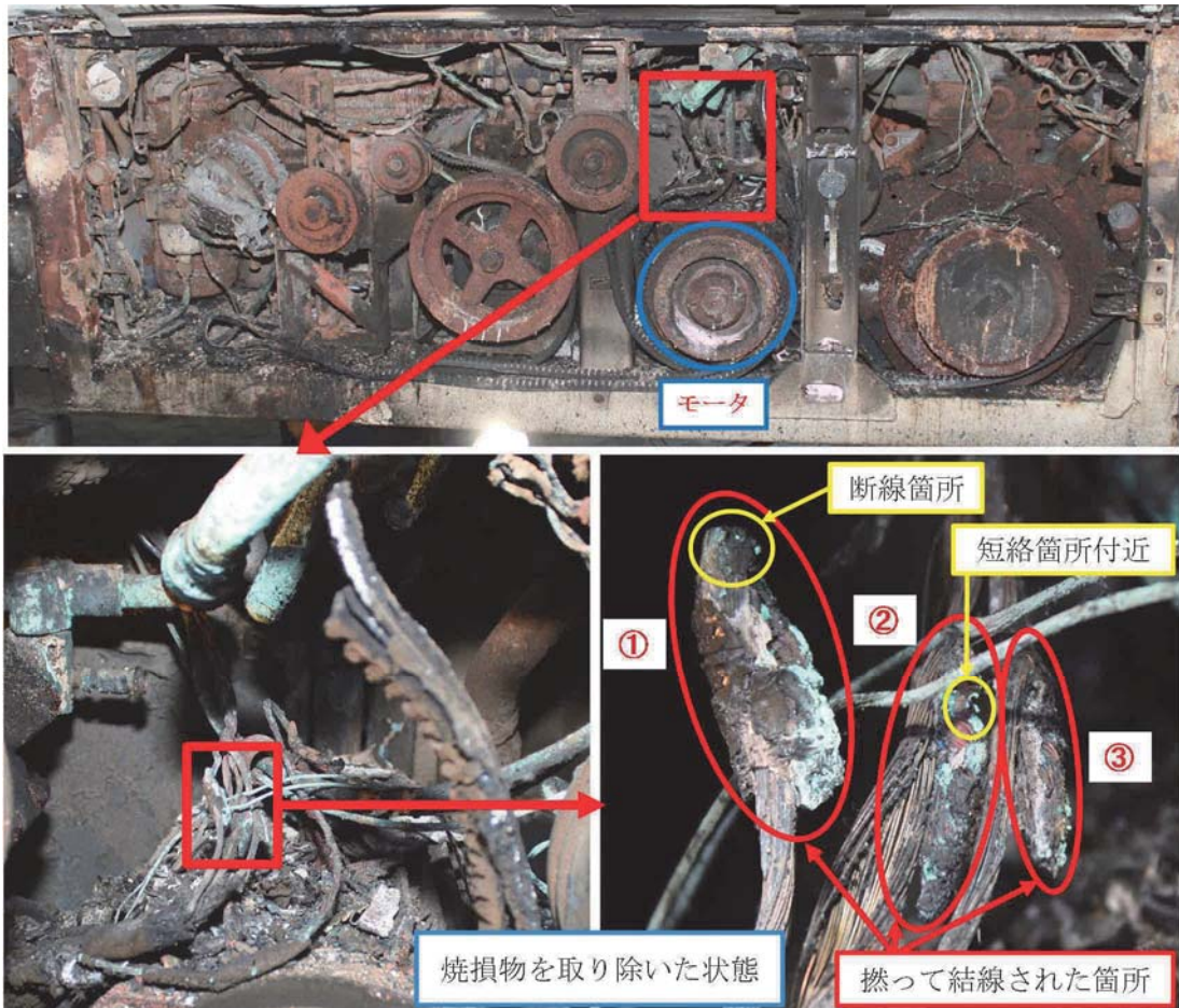
写真6 本件冷凍機の状況
