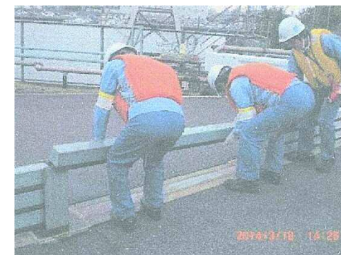
防潮堤閉鎖狀況
