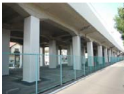
東武伊勢崎線高架橋
