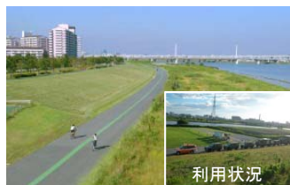
緊急用河川敷道路(荒川)
