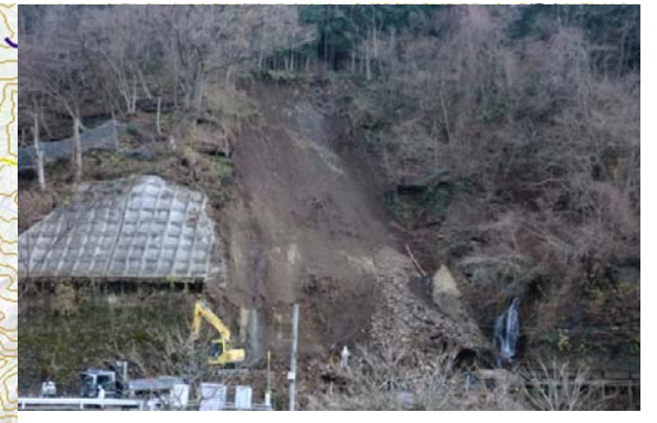
線路への土砂流入(白馬大池~千国駅間)
