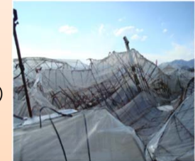
大雪により倒壊した農業用ハウス(山梨県甲州市)
