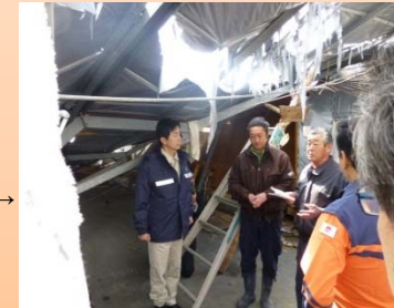
大雪により倒壊した農業用ハウス(山梨県甲州市)
