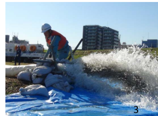
◆排水ポンプ車による排水
