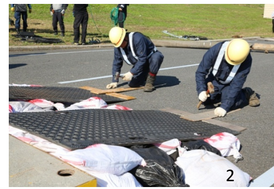
◆土のうの積上げ等による橋梁段差を解消する
