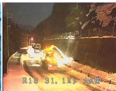
国道18号 碓氷BP 除雪作業
