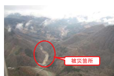
③中谷川:被災状況写真
