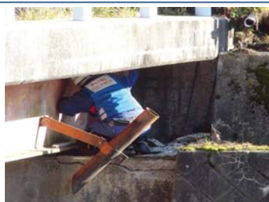
20橋梁の緊急点検の実施
