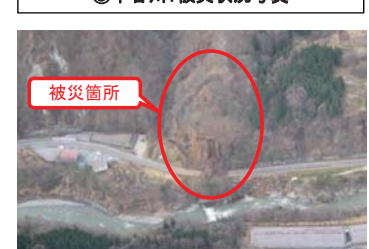
④国道148号:被災状況写真
