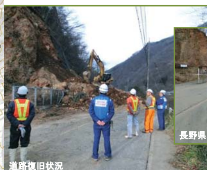
道路復旧状況
