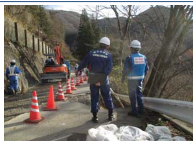
被災箇所の応急復旧工事
