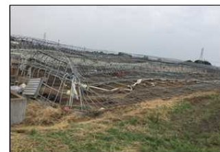
④倒壊したビニールハウス
