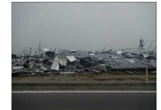
③倒壊した太陽光発電施設
