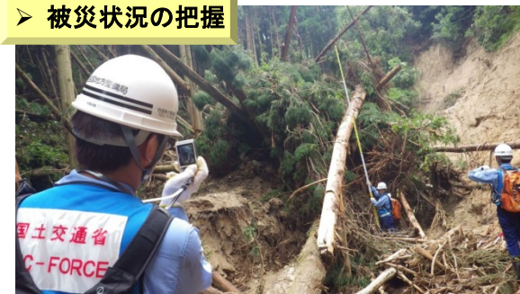
【 H26. 8 広島土砂災害 】 (広島県広島市)
