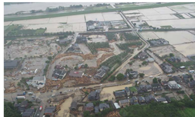
朝倉市 流木・土砂流失
