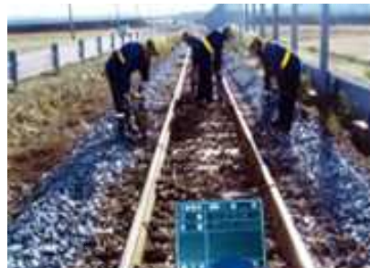
レールの修繕
