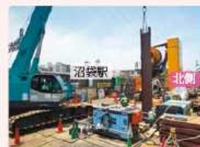
沼袋駅部 土留工事
