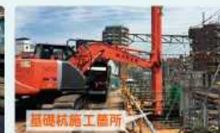
高架橋基礎杭 施工状況
