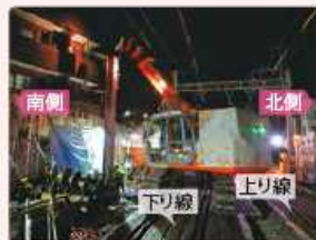
野方方 軌道仮受杭打設工事
