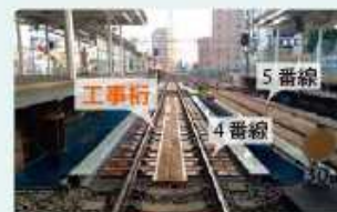
工事桁 施工状況
