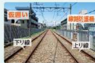
新宿線 仮囲いおよび線路防護柵 施工状況
