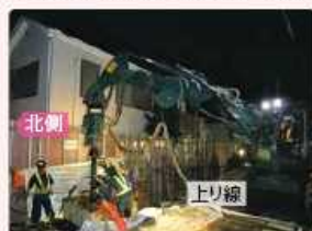
中井方 土留工事
