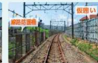
西武園線 仮囲いおよび線路防護柵 施工状況
