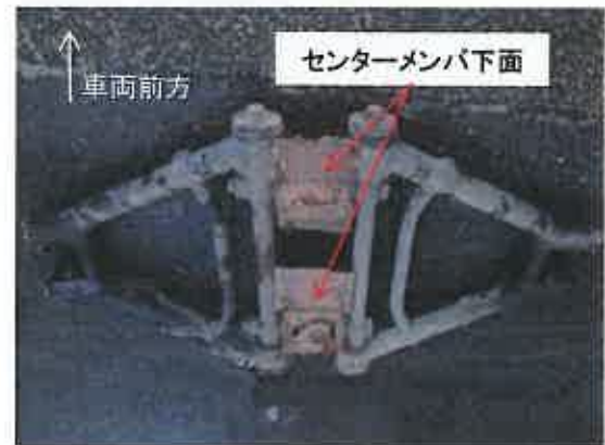
※ロアアームを車両から取り外した状態
