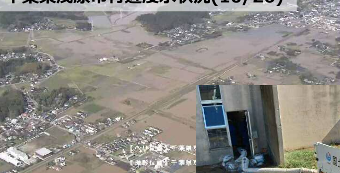
千葉県茂原市付近浸水状況(10/26)
