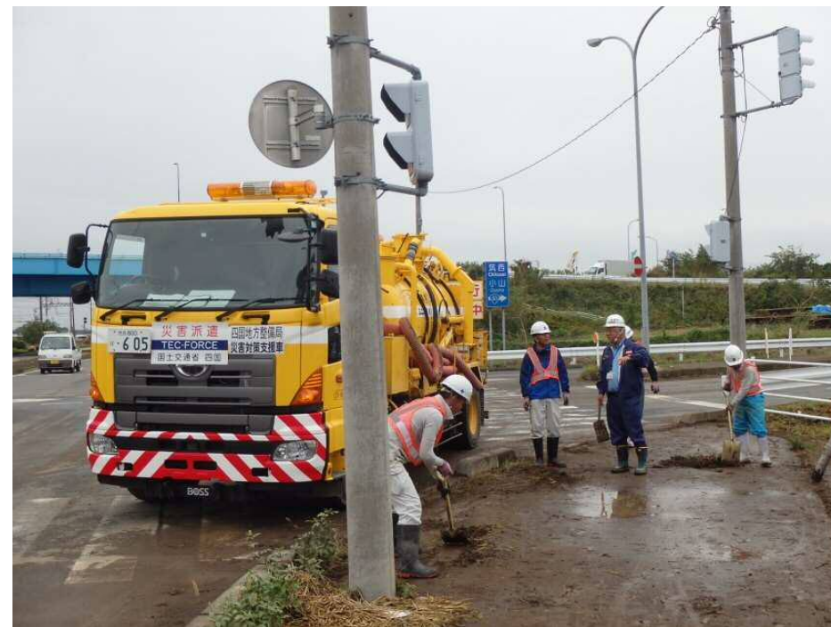
【栃木県佐野市:10/18四国地整による道路清掃】
