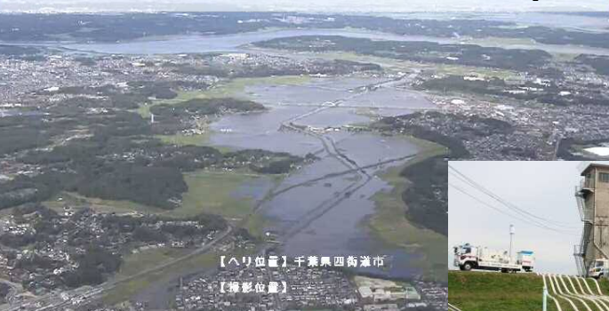
千葉県佐倉市（印旛沼）付近浸水状況(10/26)
