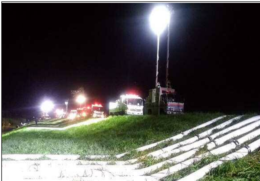
【長野県長野市:10/13近畿地整による24H排水作業】
