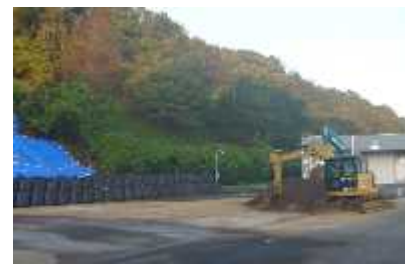
<応急措置工事の状況>
